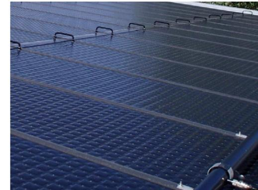
Photo: Toiture Solaire AS avec capteurs sans vitrages sélectifs
