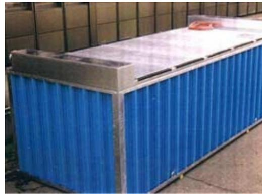
Photo: exemple d'un accumulateur de glace de taille industrielle
