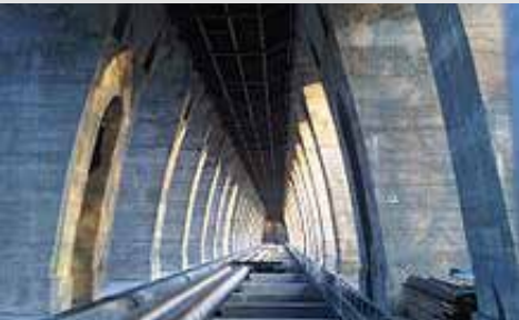
TABLIER PONT BUTIN
