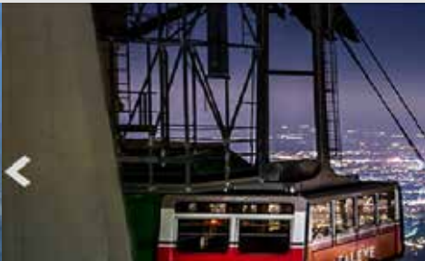
GARE SUPÉRIEURE TÉLÉPHÉRIQUE
