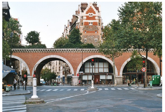
Viaduc des Arts, Paris - Arch. Patrick Berger
