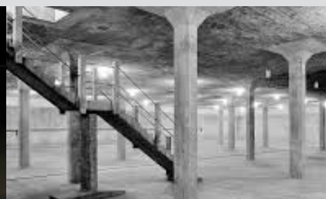
CITERNES, BOIS DE LA BÂTIE
